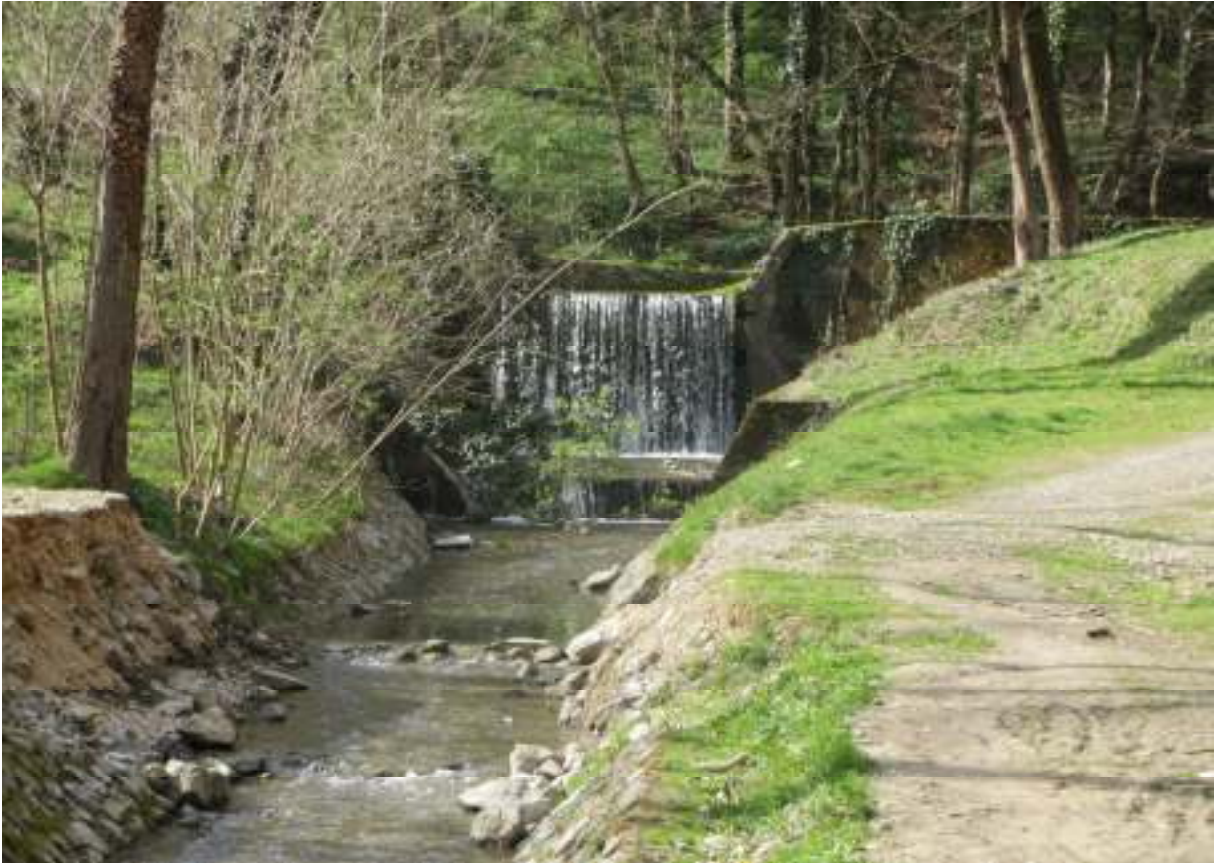
Slika 3.2. Vodna stepenica uređenog dijela vodotoka
