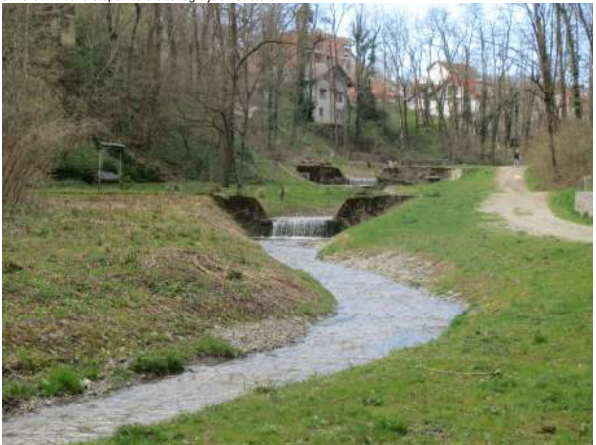
Slika 3.3. Vodna stepenica uređenog dijela vodotoka
